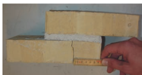
Figur 6. Brud i teglsten, fordi mørtelen er for stærk i forhold til stenen.
