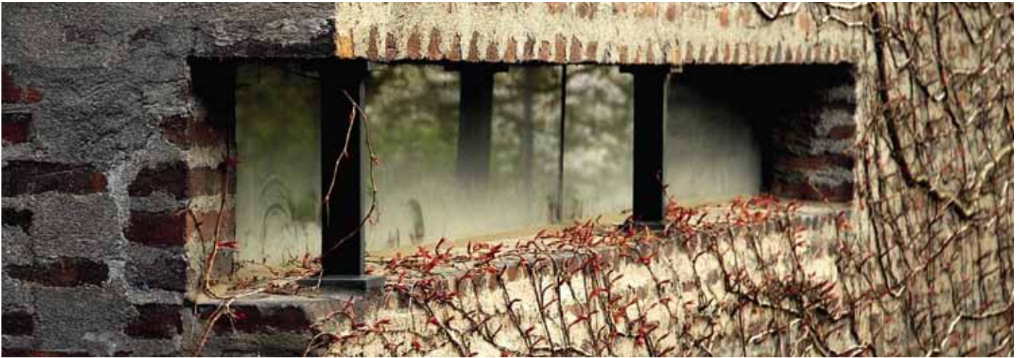
Bernt Nybergs tilbygning til Landsarkivet i Lund 1968-1971.
